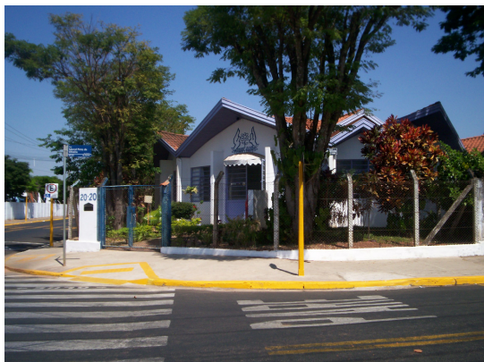
Figura 5: Vista Parcial APAE – Bauru
